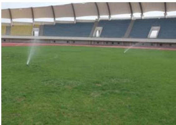
Système d'irrigation produisant une mauvaise couverture en raison du chevauchement des asperseurs
