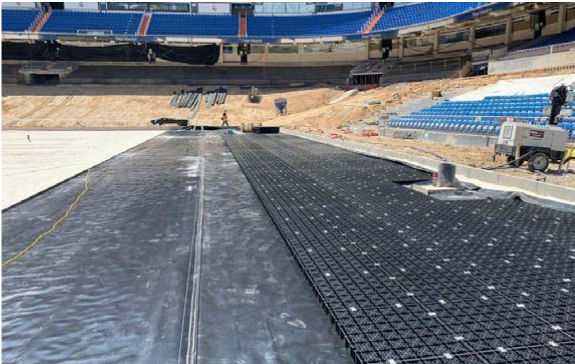
Figure 6 : Système de drainage alvéolaire en plastique renforcé
