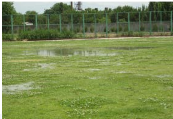
Surface inégale, mauvais drainage et invasion de mauvaises herbes
