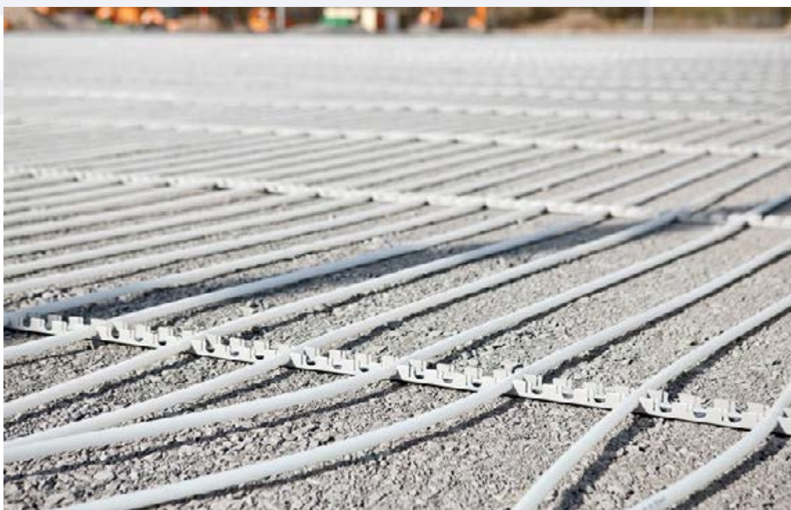
Figure 11 : Conduites d'un système de chauffage installées sur des râteliers, sur la couche de drainage en gravier, avant l'installation de la zone d'enracinement
