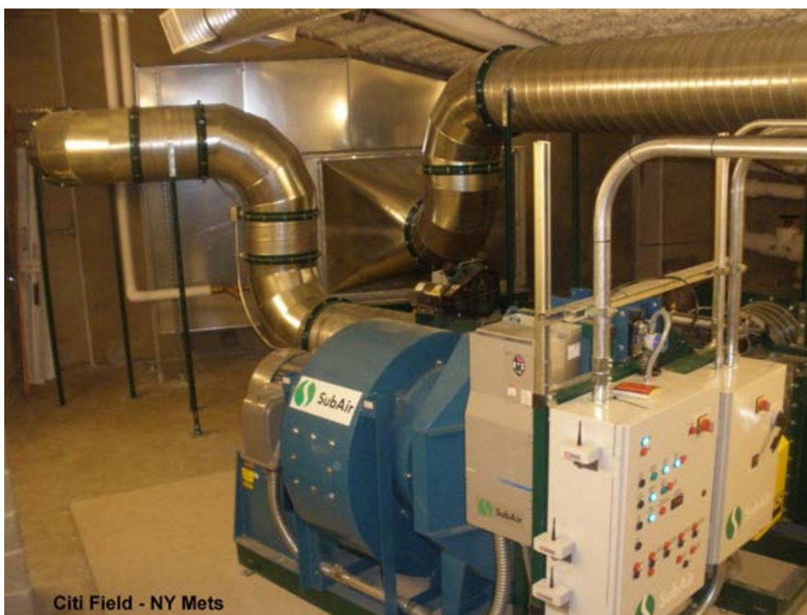
Figure 25 : Salle de l'installation SubAir d'un stade servant à l'exploitation du système d'aspiration et de ventilation
